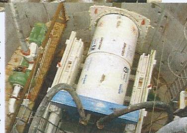
La seconde phase comprend la réalisation d'un poste de refoulement (9 m de diamètre et 15 m de profondeur), des canalisations de raccordement associées et le franchissement du fleuve Lez en micro-tunnelier. La consultation des entreprises est en cours et les travaux doivent être terminés début 2008.
