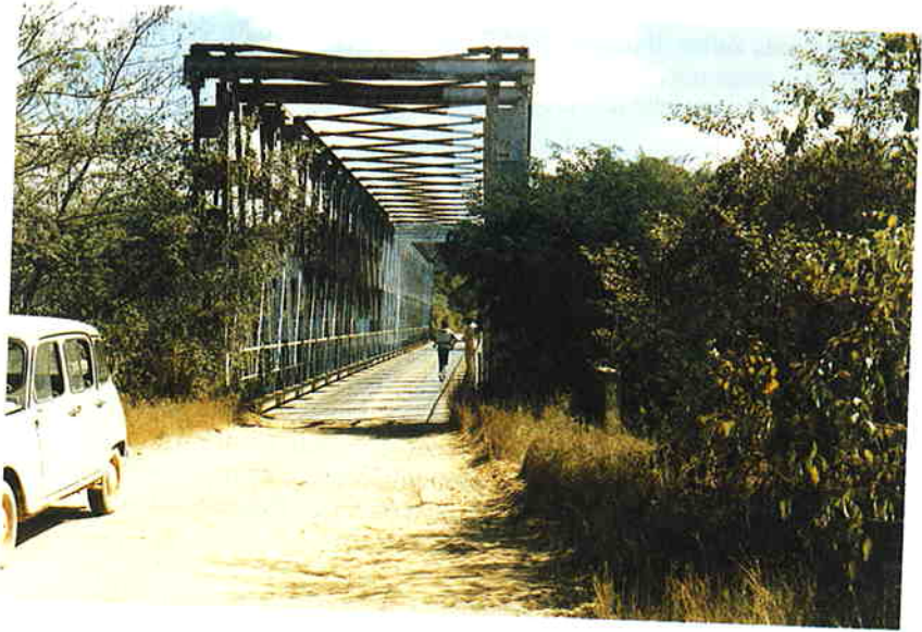
Photo 2.8.10. Pont métallique (Madagascar)
