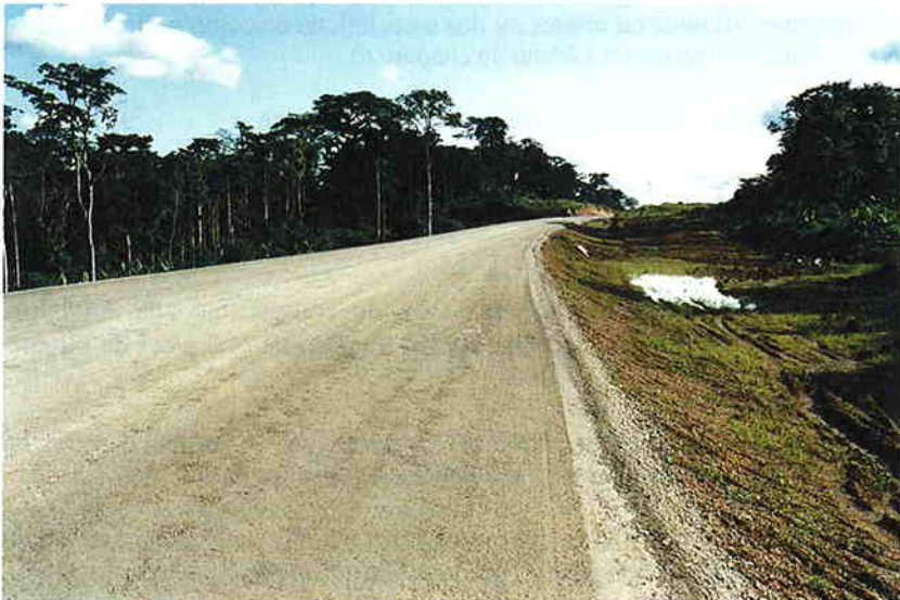
Photo 2.7.10. La même couche de base avant réglage et imprégnation
