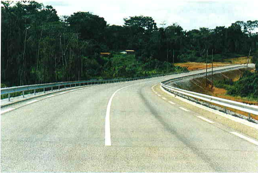
Photo 2.7.2. Route bitumée en remblai
