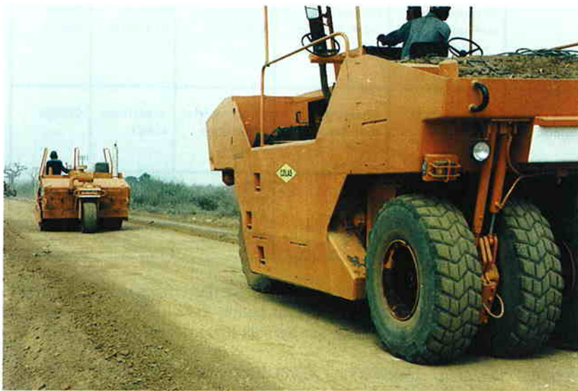
Photo 2.6.4. Atelier de compactage - compacteur vibrant et compacteur à pneus
