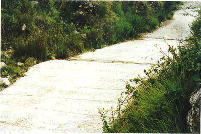
Photo 2.7.4. Route à faible trafic en béton hydraulique
