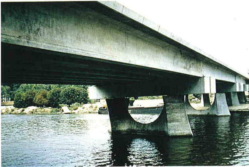
Photo 2.8.6. Pont à poutrelles
