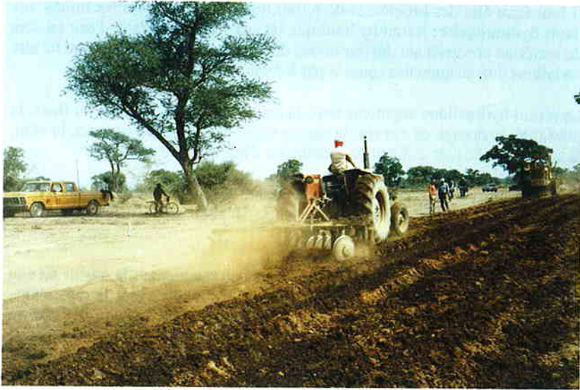
Photo 2.3.2. Malaxage de sol argileux - liant hydraulique in situ, à la charrue à disques.
