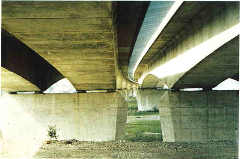
Photo 2.8.5. Pont à caissons
