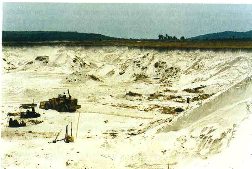
Photo 2.2.5. Emprunt de sable pulvérulent
