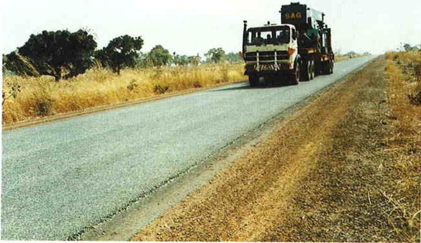
Photo 2.7.12. Enduit superficiel bicouche L'imprégnation recouvre le bord de l'accotement
