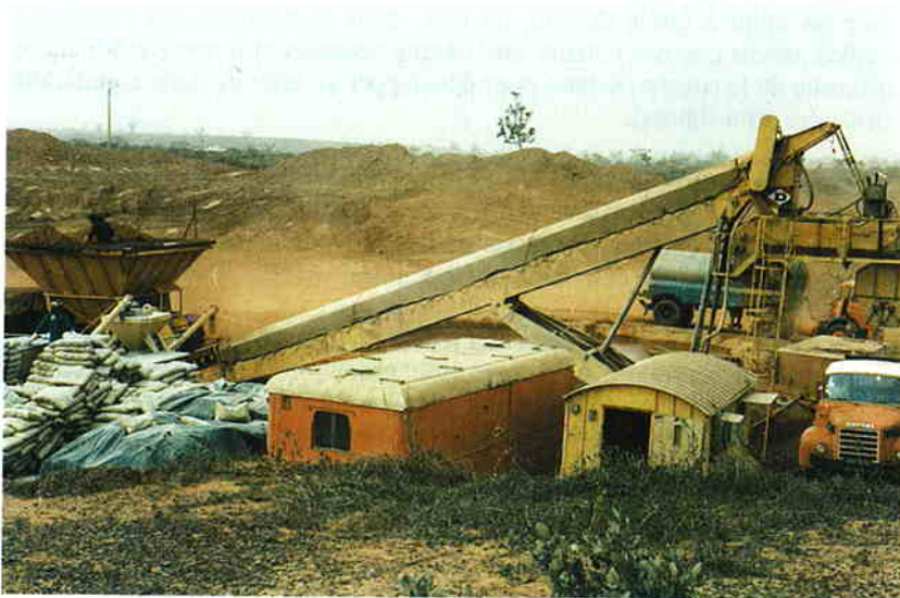
Photo 2.3.3. Mini centrale de traitement au ciment de graveleux latéritique
