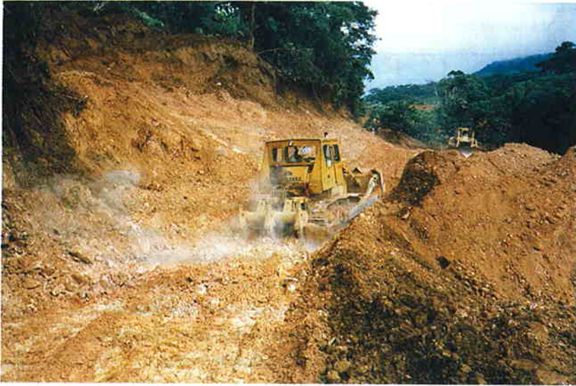
Photo 2.6.1. Ouverture de déblais dans des grès, à l'aide d'un bulldozer équipé d'un ripper à trois dents
