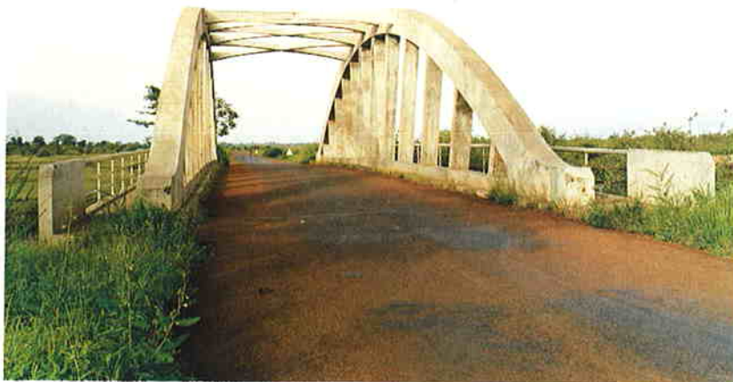
Photo 2.8.9. Pont en arc avec tirant
