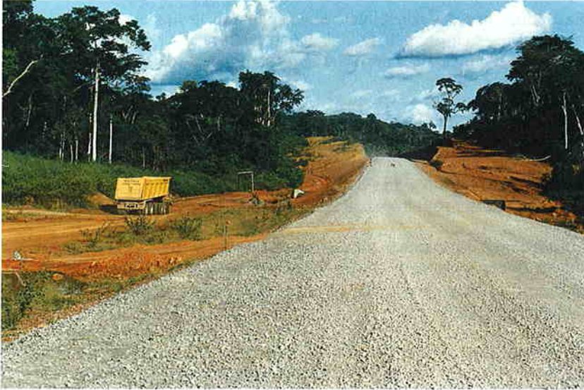
Photo 2.7.9. Couche de base approvisionnée en concassé de gneiss
