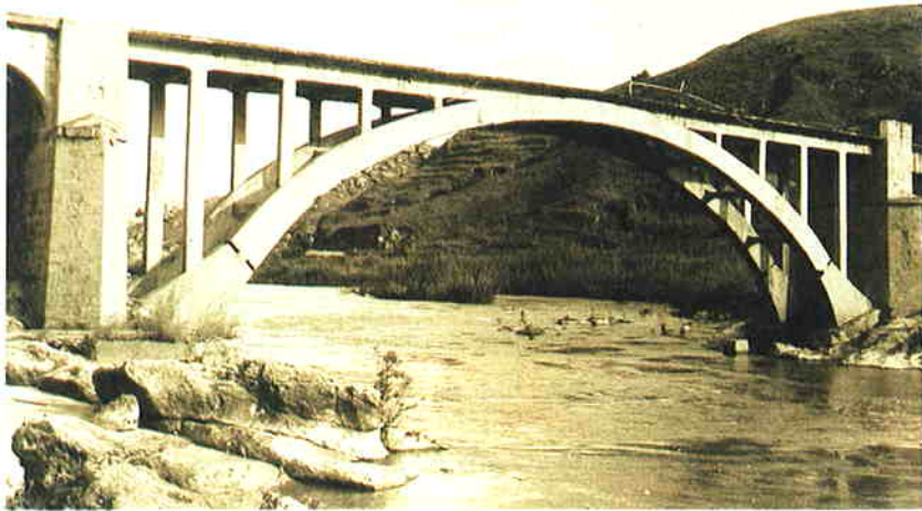
Photo 2.8.8. Pont en arc
