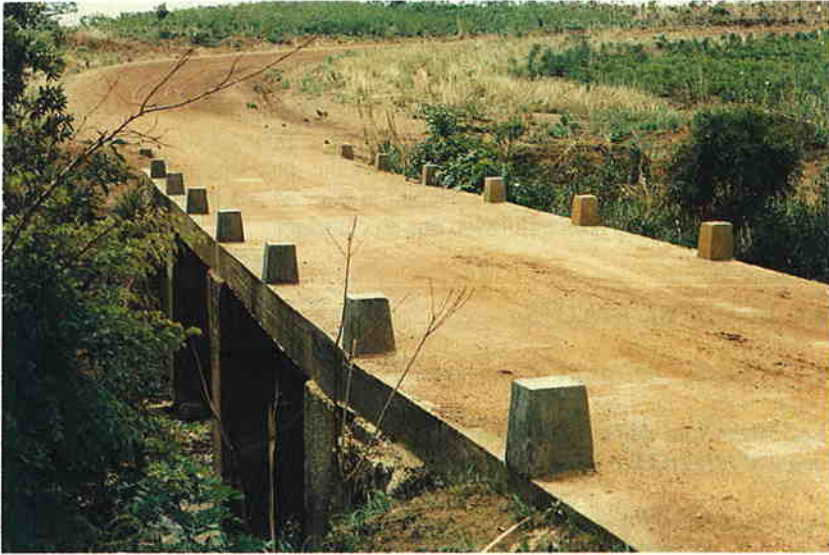
Photo 2.8.13. Pont submersible
