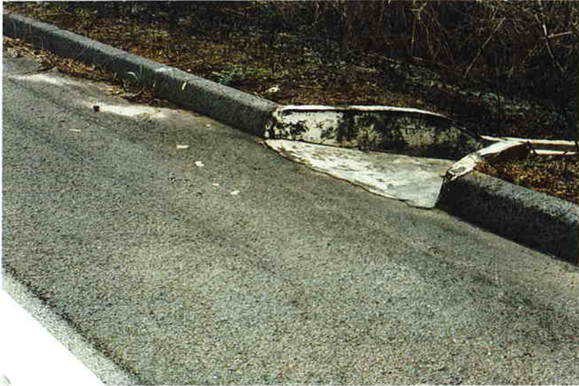
Photo 2.7.8. Accotement revêtu d'un bicouche
