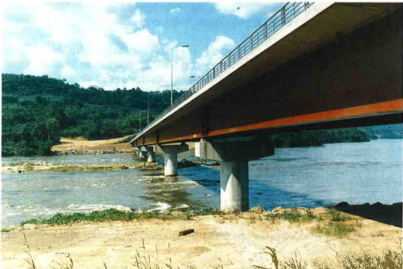
Photo 2.8.11. Pont à ossature mixte
