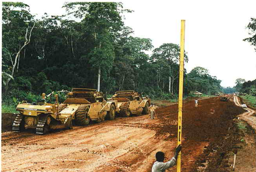
Photo 2.6.3. Chantier de terrassement en forêt
