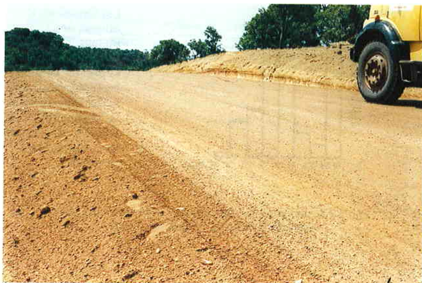
Photo 2.2.3. Utilisation d'un graveleux latéritique en rechargement de route en terre
