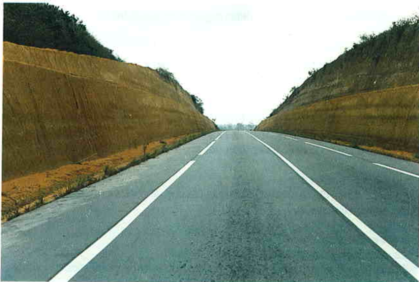
Photo 2.7.1. Route bitumée en déblai
