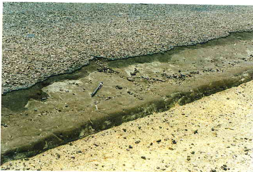
Photo 2.3.5. Couche de base en sable-bitume
