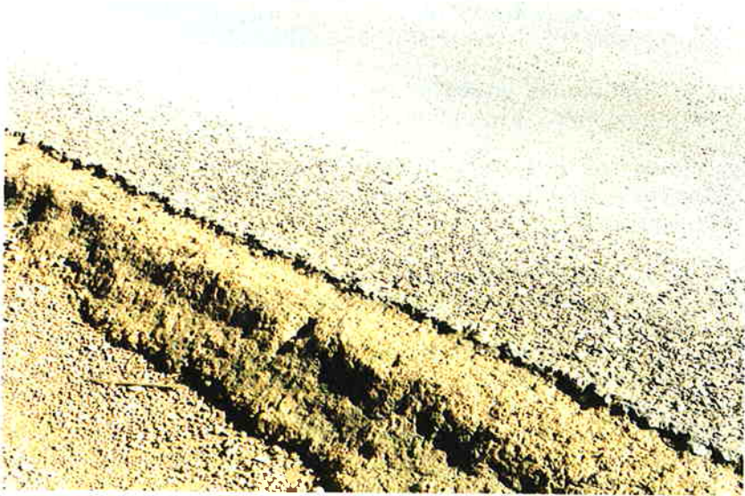
Photo 2.3.4. Grave naturelle traitée au ciment
