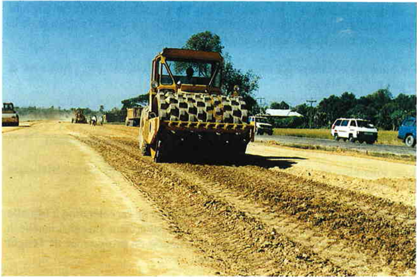
Photo 2.6.5. Compactage de limons à l'aide d'un compacteur à pieds dameurs
